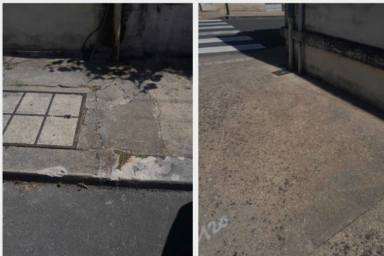
Vue(s) du point de rejet en dehors de la parcelle
