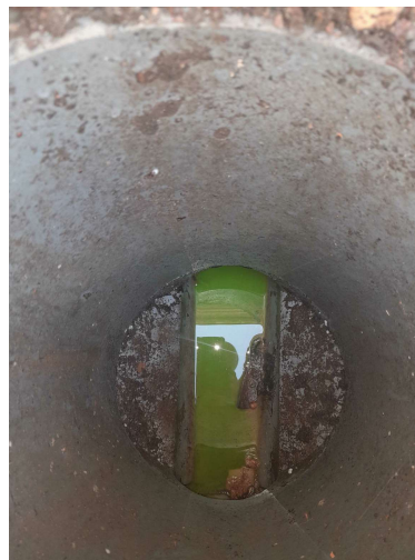
Vue intérieure du branchement
